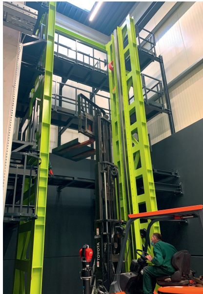
Bild 2. Während des Messvorgangs mit dem Radian Laser Tracker beim Ausrichten, Nivellieren und Verifizieren: Die Experten von API Services und die Monteure von HEGGEMANN AG können parallel arbeiten.
