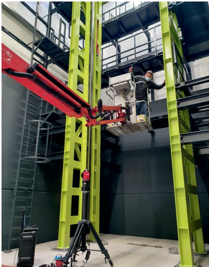
Bild 1. Die Verantwortlichen der Heggemann AG beauftragten das Team von API Services mit den Messungen, um sicherzustellen, dass die Schienen des Prüfstands im richtigen Abstand zueinander aufgestellt wurden und über die gesamte Höhe von neun Metern exakt senkrecht blieben.
